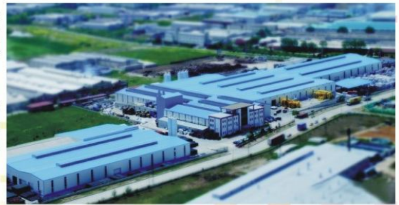
GF Hakan Plastik Çerkezköy Factory
