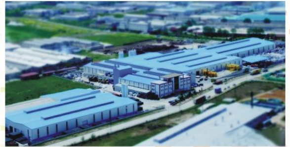
GF Hakan Plastik Çerkezköy Factory
